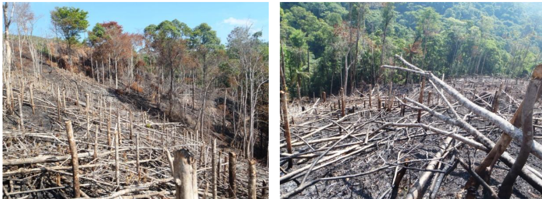
Vista panorámica del descombro
