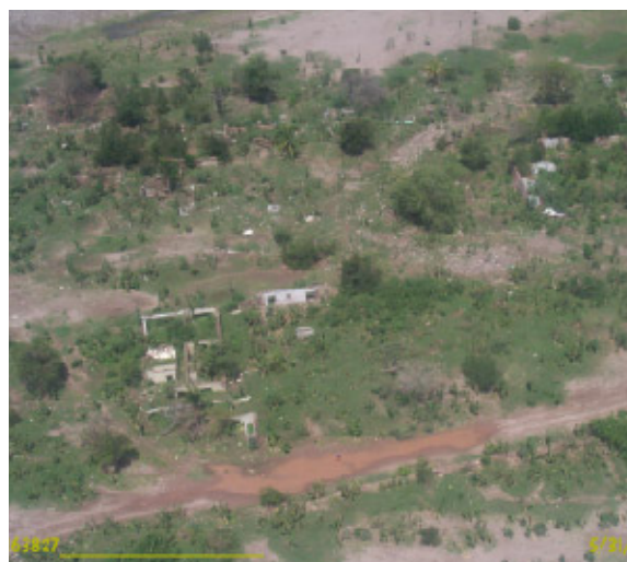
Daños ocasionados por el huracán y tormenta tropical Mitch por el desbordamiento del río Choluteca
