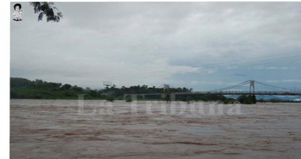
La tormenta tropical "Agatha" provocó la crecida del Río Choluteca y daños en esta zona.
