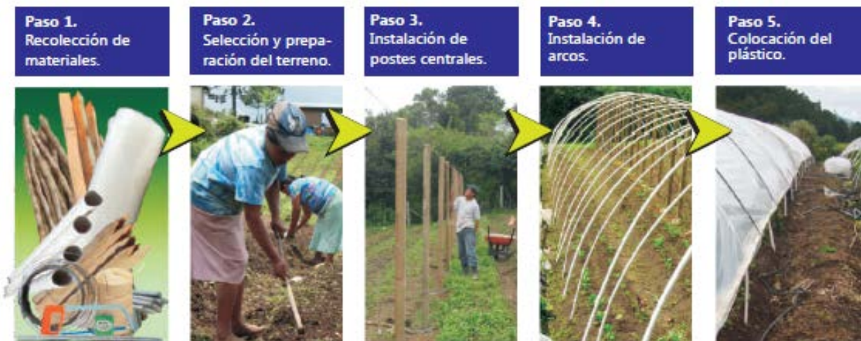
Diagrama 1. Pasos generales para la construcción de un macrotúnel.
