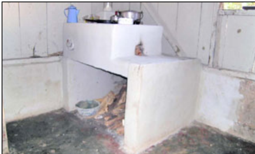
Estufa con base de bloques y plancha con cemento, dejando espacio para guardar leña.
