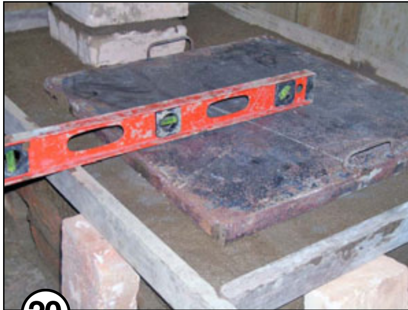
19 Colocar la plancha.
