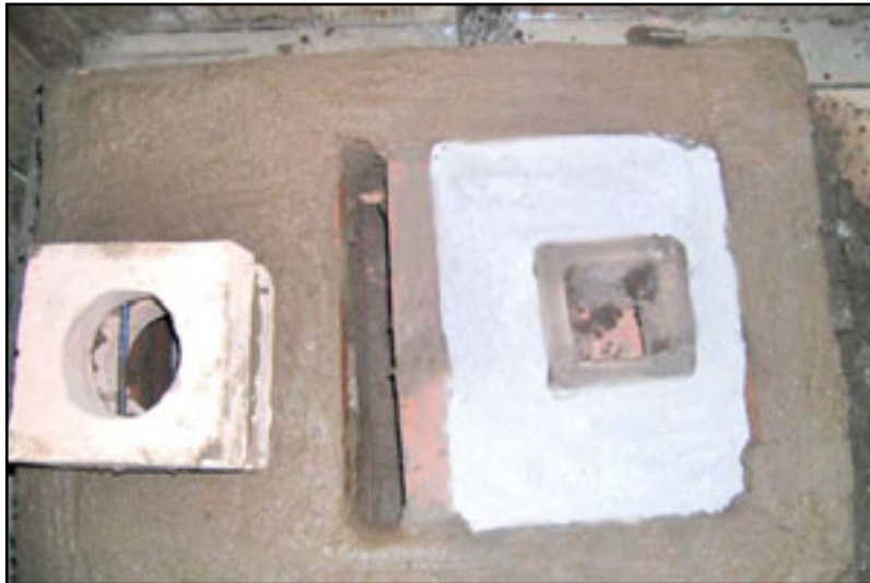
Vista superior de la estufa con la base de la chimenea instalada y la cámara aisladora llena con ceniza
