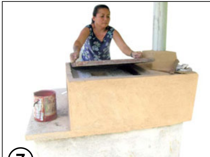
6 Rellenar con ceniza la cámara aisladora.
