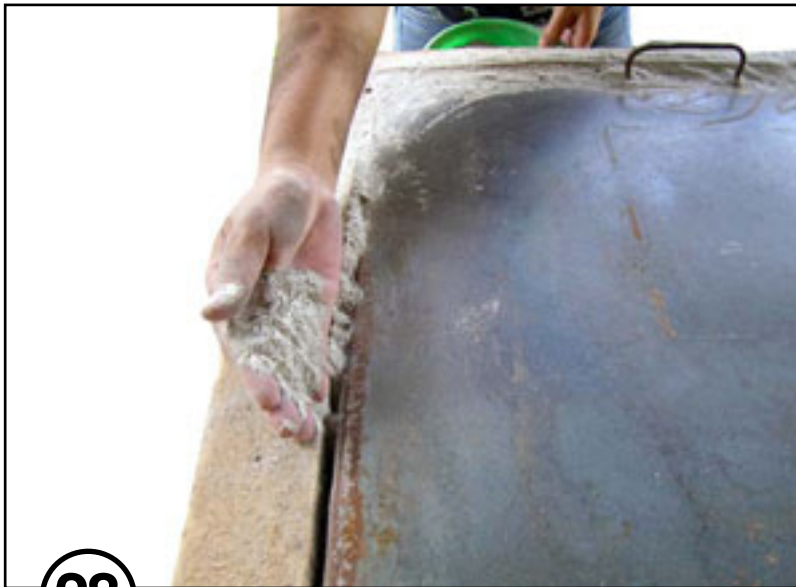
Rellenar con ceniza la ranura para evitar la salida de humo.
