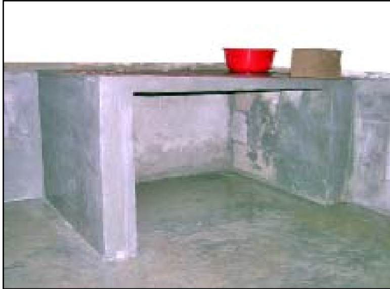
Construido con bloques y plancha de cemento.
