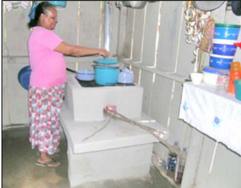
Estufa con base de bloques y plancha con cemento.
