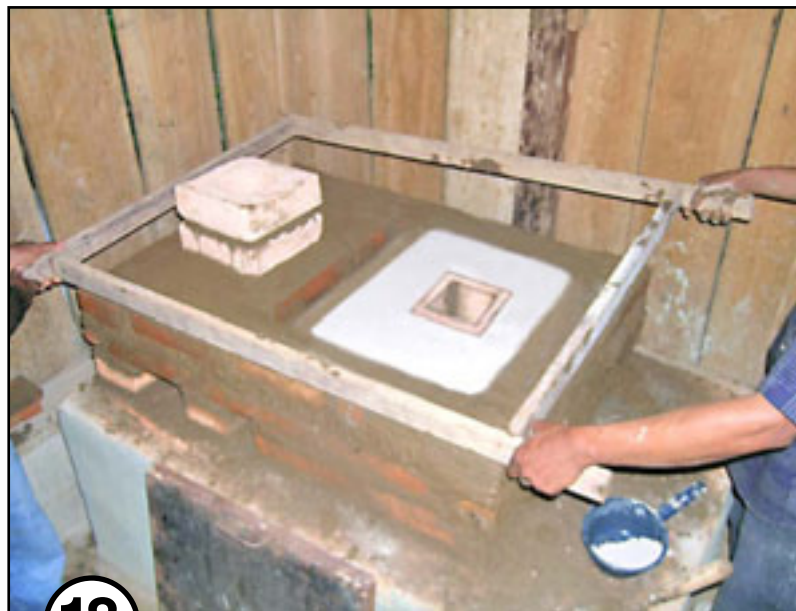
Vista superior de la estufa con la base de la chimenea instalada y la cámara aisladora llena con ceniza
