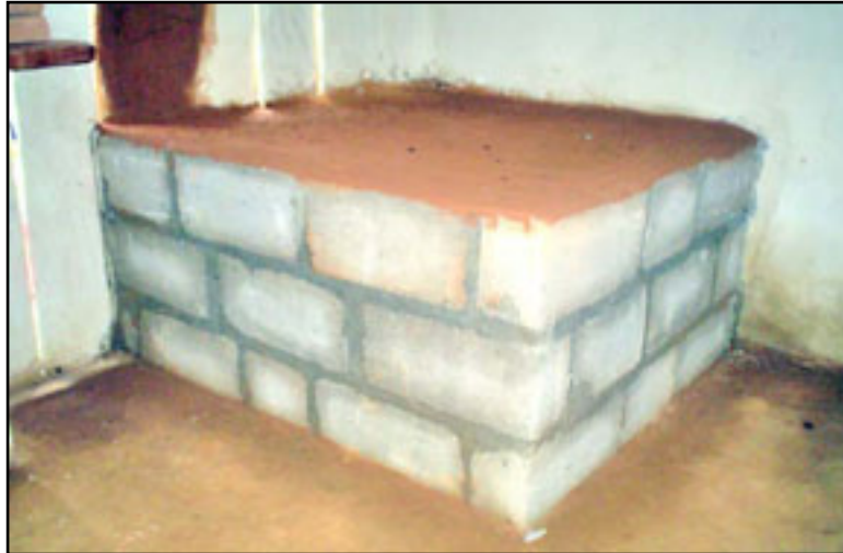
Construido con bloques y relleno con piedra y tierra.
