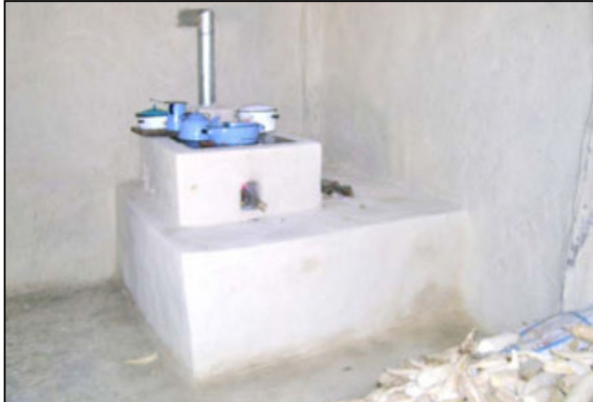
Estufa con base de tierra y piedras. Se instaló un codo en la chimenea debido a que la casa tiene techo construido con manaca.
