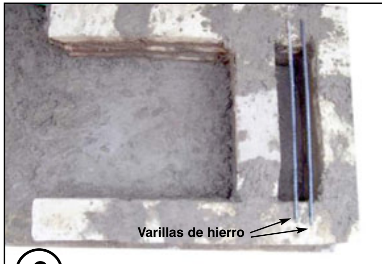
Vista superior de la estufa con la tercera hilada de ladrillos terminada.
