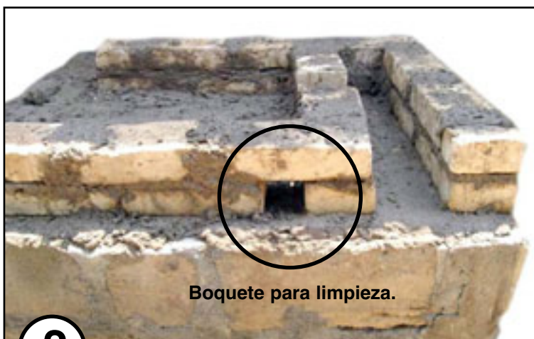
Vista superior de la estufa construida con la primera hilada de ladrillos.
