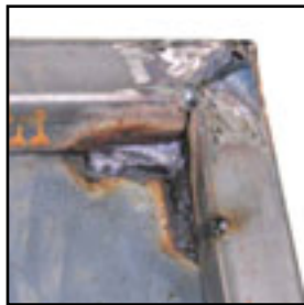
Plancha metálica soldada con tubo industrial.
