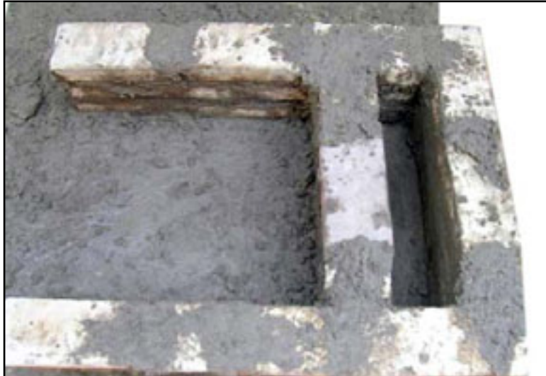
Vista superior de la estufa con la tercera hilada de ladrillos terminada.
