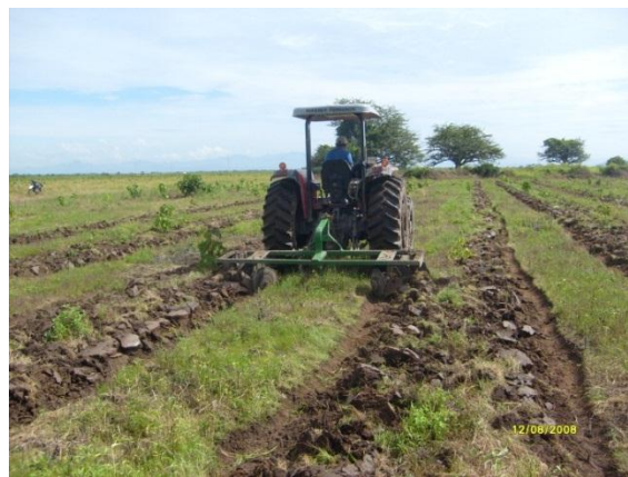
Imagen 22: Construcción de drenajes
