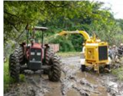
Imagen 17: Uso maquinaria para limpieza terreno
