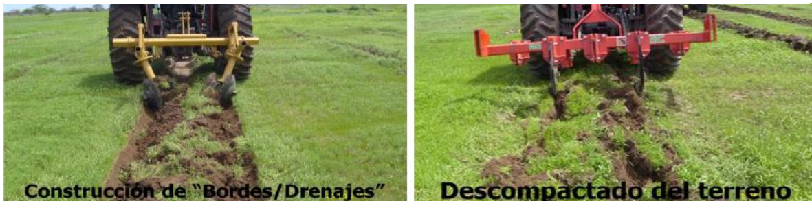
Imagen 15: Obras a realizar para habilitar terrenos compactados
